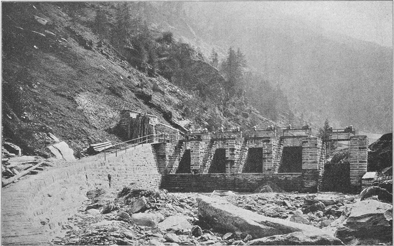
Abb. 6. Ansicht des Kanal-Stauwehrs in der Saaser Visp von der Unterwasserseite; rechts der Grundablass.
