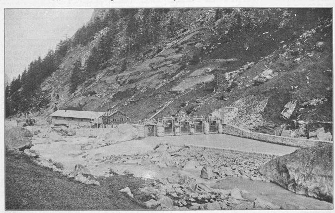
Abb. 4. Gesamtansicht der Fassung bei Saas-Balen mit Kläranlage und Wärterhaus (letzteres noch im Bau).
