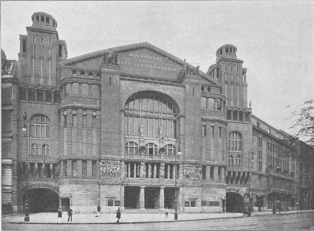
Abb. 5. Fassade mit Haupteingang und Einfahrten am Nollendorfplatz.
