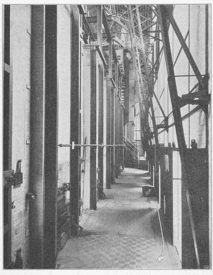
Abb. 19. Vertikalöfen: Generatorenseite mit Schlackentüren. Hinten die Dampfabzugschlote.
