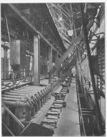
Abb. 17. Vertikalöfen: Liegerohre, Gasabgangsrohre mit Teervorlagen und Laufsteg.
