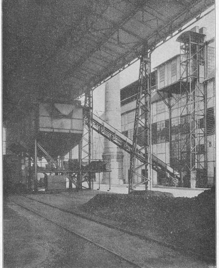
Abb. 15. Ofenhaus II mit Kokstransportrinne vom Ofenhaus nach der Koksaufbereitungsanlage unter der Kokshalle. Elektrischer Koksaufzug mit Motorhäuschen.
