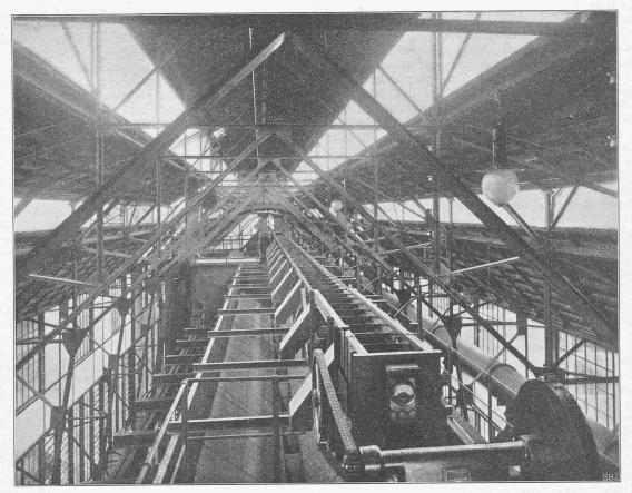
Abb. 14. Kohlenbehälter mit Kratzertransporteuren über den Oefen. Hinten: Bogenführung (höchster Punkt) der Bradley-Becherwerke zur Abgabe der Kohlen auf die Kratzertransporteure.
