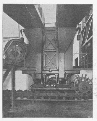
Abb. 10. Oben: Ende der Grobkohlenbeförderung. Links: Kohlenbrecher. In der Mitte: die beiden Einwurftrichter mit Vertikalschurren und Materialzubringer auf die Becherwerke. Rechts unten: Untere Antriebsvorrichtung für die Becherwerke.
