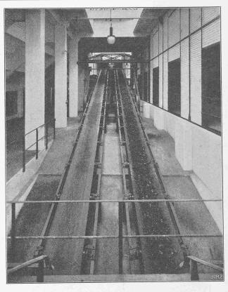
Abb. 9. Kanal zwischen Kohlenschuppen und Ofenhaus zur Aufnahme der schrägen Kohlen-Bandförderer, hinten die beiden rechteckigen Oeffnungen zum Einwurf in die Kohlenbrecher.
