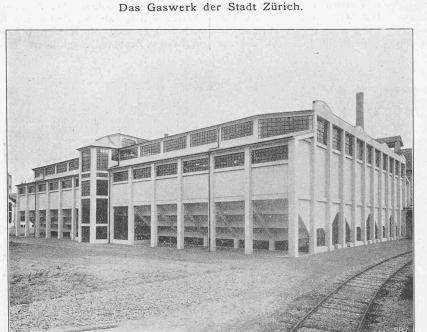
Abb. 6. Kohlenschuppen II aus Eisenbeton (Ansicht von Norden). — Inhalt 13000 t.
