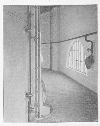
Abb. 11. Obere Revisionsgalerie und Standröhren am Behälter.
