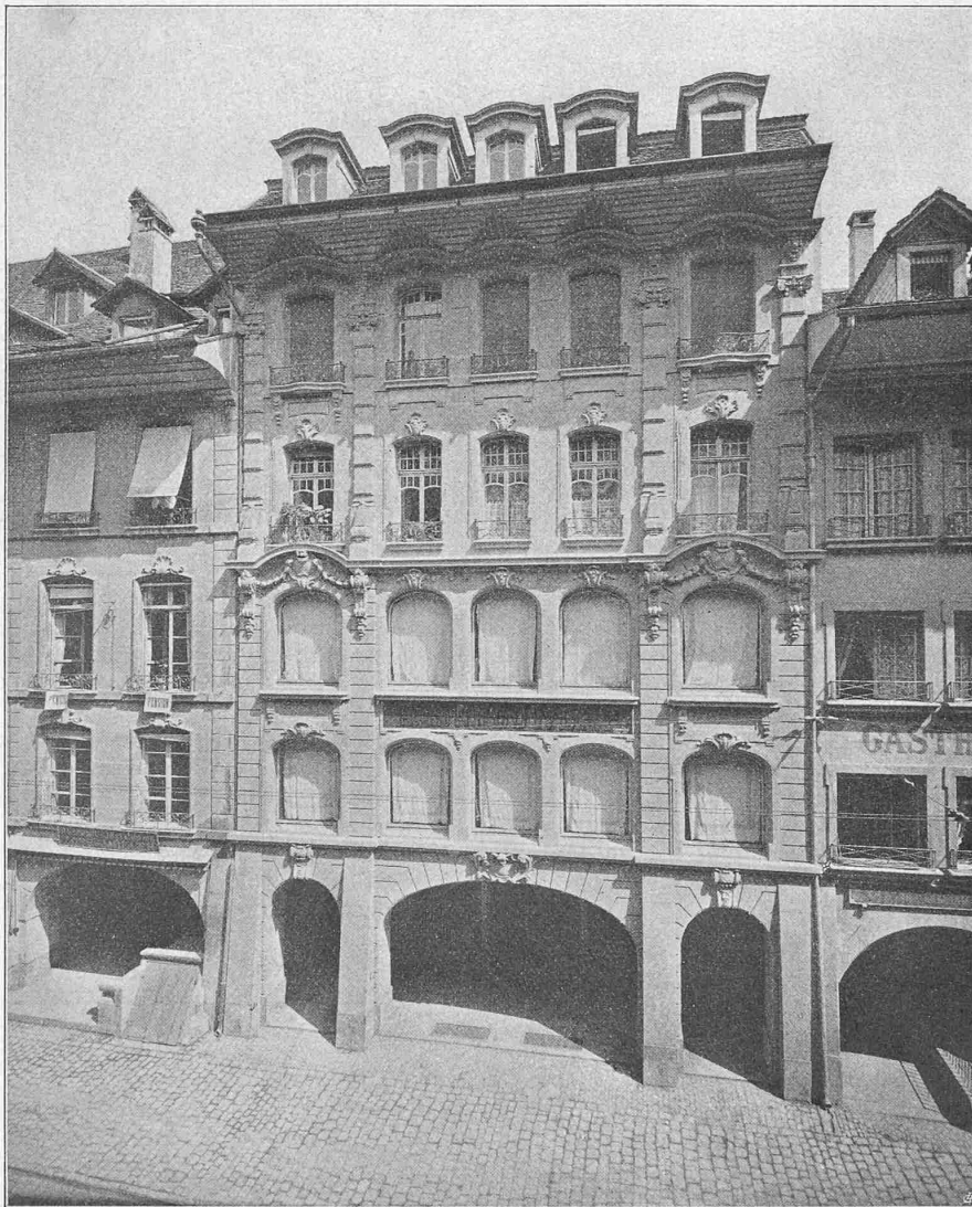
Abb. 10. Fassade und Laubengang an der Marktgasse.
