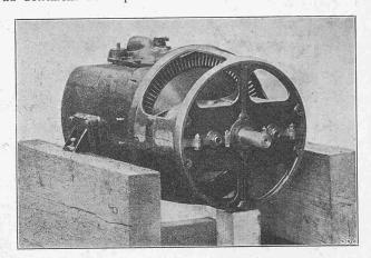
Fig. 4. Turbine à pétrole pour torpille automobile.
