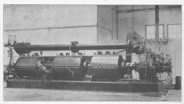
Fig. 5. Compresseur et turbine à pétrole. Disposition définitive de la chambre de combustion.
