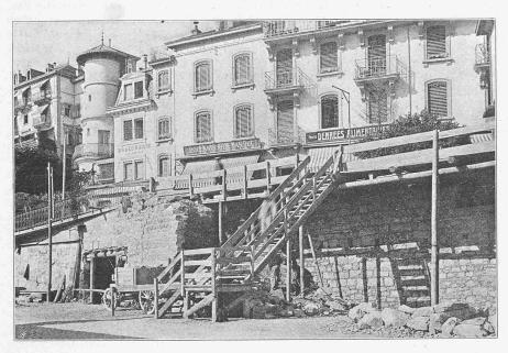
Abb. 5. Stollen für das linke Widerlager (B-B in Abb. 4) des Tunnels unter dem Hause Nr. 2.
