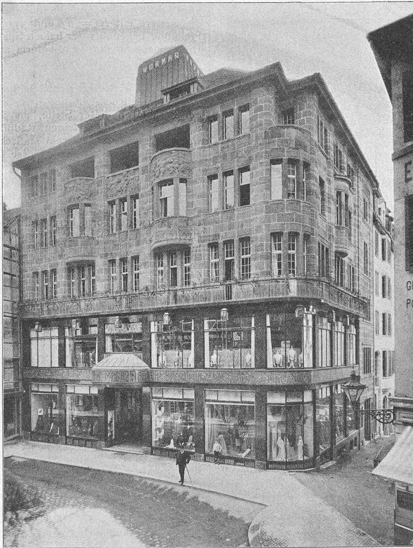
Abb. 8. Gesamtansicht von der Eisengasse aus.
