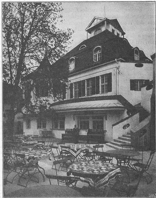
Abb. 5. Freitreppe, Aufgang zur oberen Terrasse.
