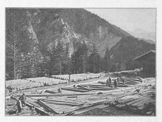
Abb. 29. Reissboden für die Lehrgerüst-Binder auf dem Stationsplatz Wiesen. Links im Hintergrund Beton-Gewölbsteine in den Formkasten.
