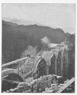
Abb. 34. Mauerung der rechtsufrigen Seitenöffaungen am Wiesener Viadukt mit Beton-Formsteinen.
