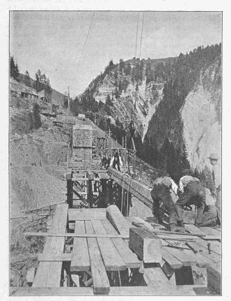
Abb. 31. Schliessen der vorgebauten Teile des Lehrgerüstes über der Mittelöffnung. — Erbauer Zimmermeister R. Coray in Trins.
