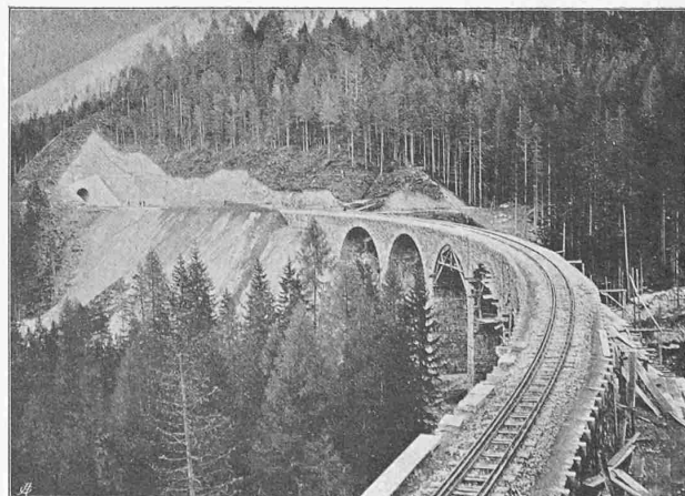
Abb. 15. Cavia-Viadukt, taleinwärts gesehen. Steilgeböschter Tunnel-Voreinschnitt in der Rauhwacke.
