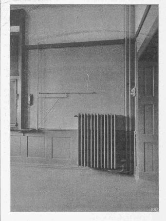
Abb. 25. Inselschule Basel; Heizkörper mit automat. Johnson-Regelung.
