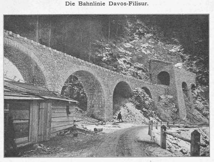
Abb. 7. Portal des Eistöbelitunnels mit Steinschlag-Galerie.
