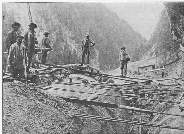
Abbildungen 8 und 9. Armierung der Steinschlag-Galerie am oberen Portal des Silberbergtunnels.
