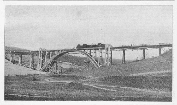
Abb. 1. Eisenbeton-Bogenbrücke der ungarischen Lokalbahn Fogaras-Kronstadt. — Spannweite der Hauptöffnung 60 m.
