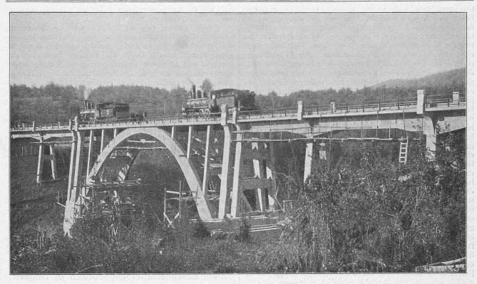
Abb. 2. Eisenbeton-Bogenbrücke der ungarischen Lokalbahn Fogaras-Kronstadt. — Spannweite der Bogenöffnung 36 m.
