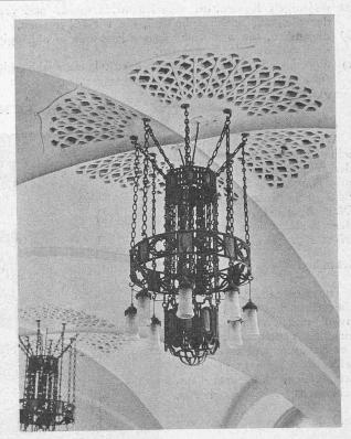
Abb. 9. Beleuchtungskörper und Ventilationsöffnungen in der «Halle».
