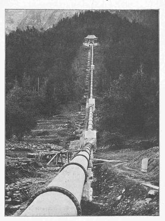
Abb. 17. Wasserschloss und Druckleitung I.
