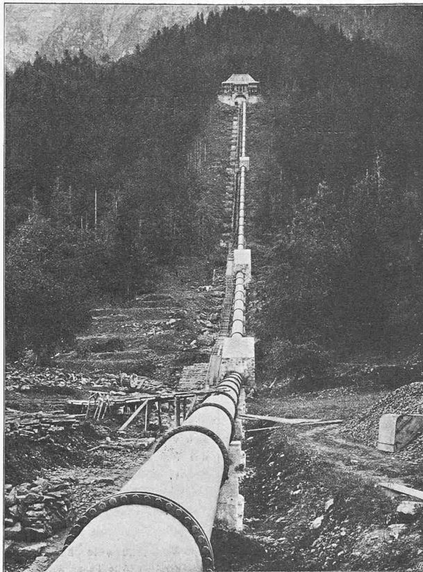
Abb. 17. Wasserschloss und Druckleitung I.
