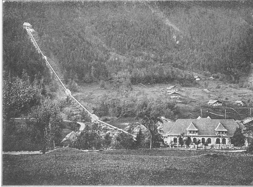
Abb. 15. Wasserschloss, Druckleitung und Maschinenhaus.
