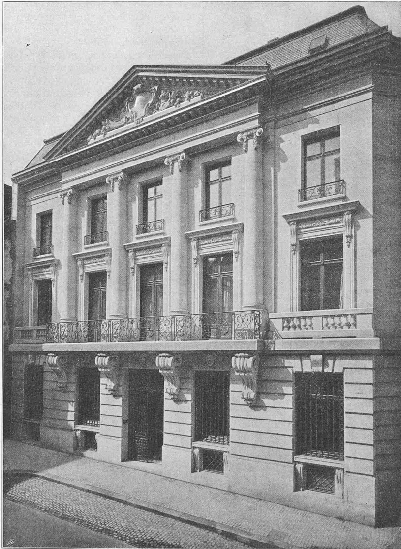
Abb. 5. Fassade an der Freiestrasse.
