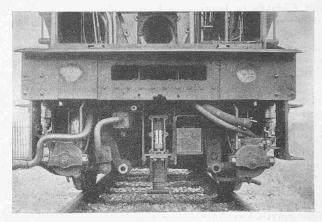
Abb. 1. Kontaktvorrichtung unter dem Führerstand der Lokomotive.
