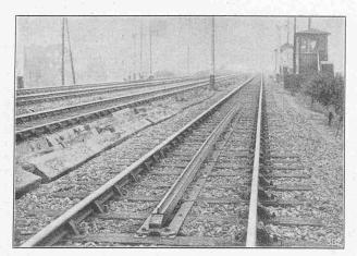
Abb. 3 Rampe mit Kontaktschiene.
