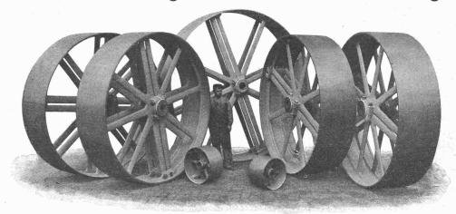
Gusseiserne Riemenscheiben für Hauptantriebe, bis 3300 mm Durchmesser geliefert.
