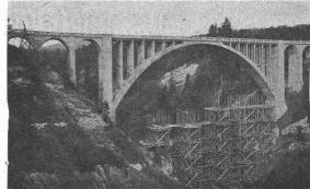
Gmündertobelbrücke; grösster Bogen in armiertem Beton von 79 m Vollendet 1908. Spannweite.
