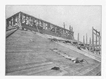
Abb. 17. Ventilationsaufsatz und Gewölbeabdeckung.
