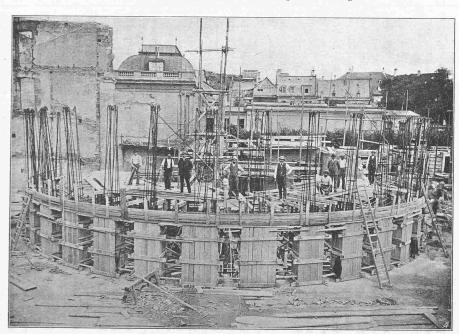
Abb. 6. Pfeiler und ringförmiger Balken im Balkonrang und I. Rang.
