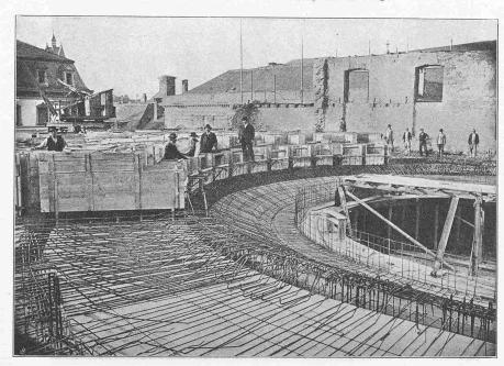
Abb. 8. Armierung im II. Rang; Einschalung der rippenförmigen Träger.
