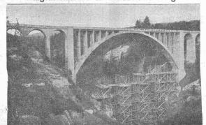
Gmündertobelbrücke; grosster Bogen in armiertem Beton von 79 m Spannweite. Vollendet 1908.
