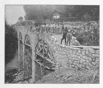
Abb. 5. Viadukt bei Fayot im Bau.
