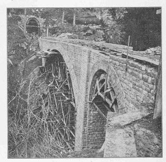
Abb. 7. Die Brücke «La Tine» im Bau. Seitenansicht.
