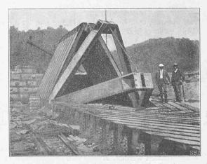
Abb. 2. «A»-Bockwehr von F. B. Thomas, im Ohio-Fluss.
