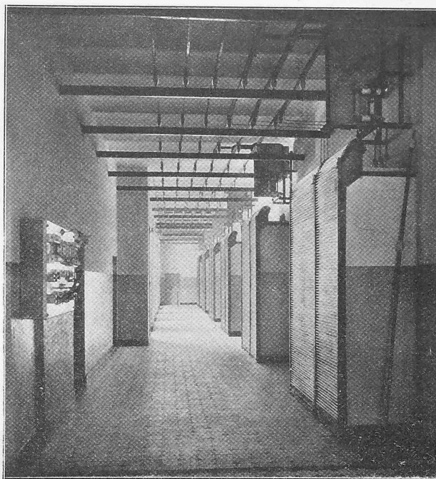
Abb. 42. Apparatenraum und Hochspannungs-Sammelschienen.
