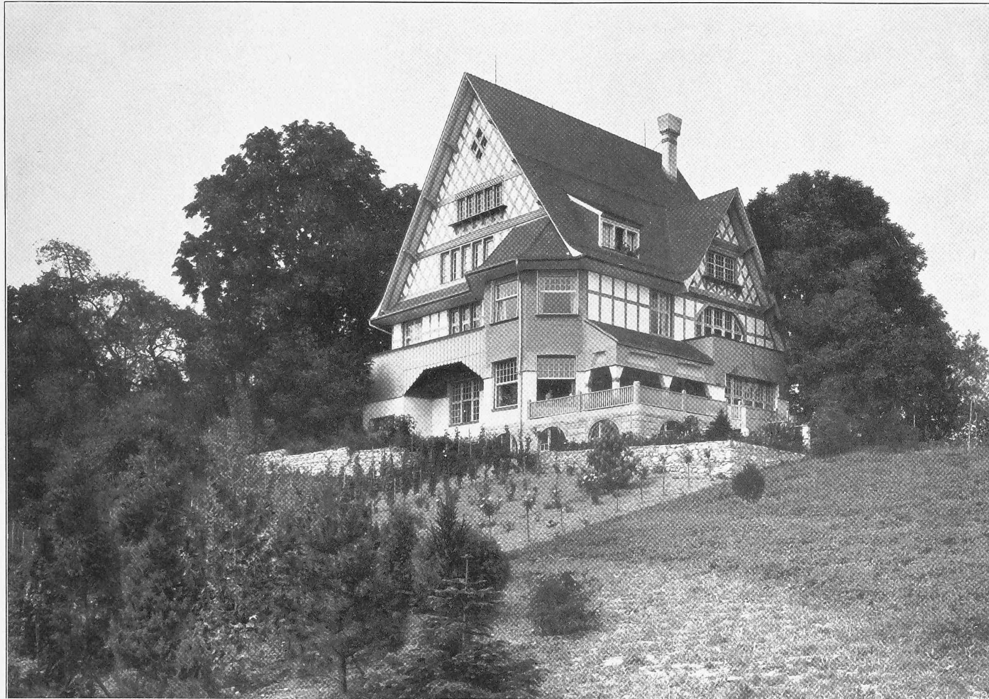
Das Landhaus Obereggbühl bei Höngg (Kt. Zürich).
