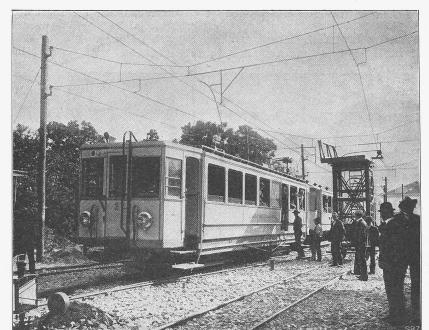
Abb. 13. Ansicht des Motorwagens und der Fahrdrahtaufhängung.
