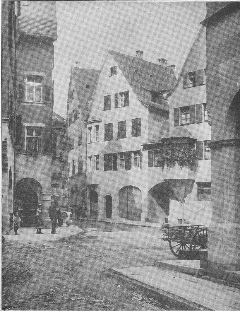
Abb. 8. Altstadt-Neubauten in Stuttgart. — Architekt: Baurat Karl Hengerer in Stuttgart.
