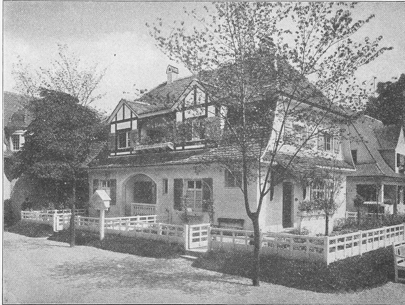
Abb. 4. Zweifamilienhaus für die Arbeiterkolonie Gmindersdorf bei Reutlingen. Architekt: Professor Theodor Fischer in München.
