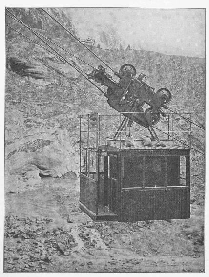
Abb. 13. Ansicht des Bremswagens mit der Kabine.
