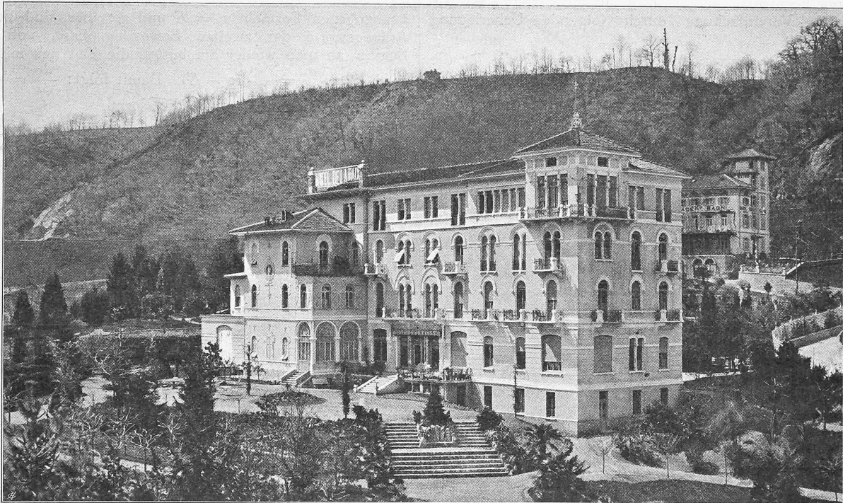
Abb. 5. Ansicht des Hotels von Südosten.
