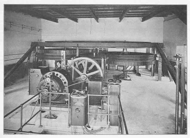
Abb. 8. Das Windwerk im Maschinenraum der obern Station.
