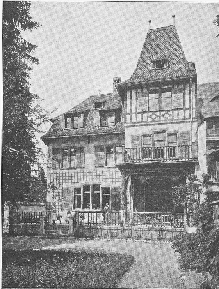
Abb. 41. Wohnhaus Gellertstrasse 14. — Gartenfassade nach Süden. Erbaut von La Roche, Stähelin & Cie., Architekten in Basel.
