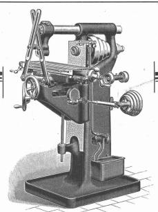
EINFACHE FRÄSMASCHINE Nr. 1 MIT VORSCHUBWECHSEL :: DURCH STUFENSCHEIBEN ::
