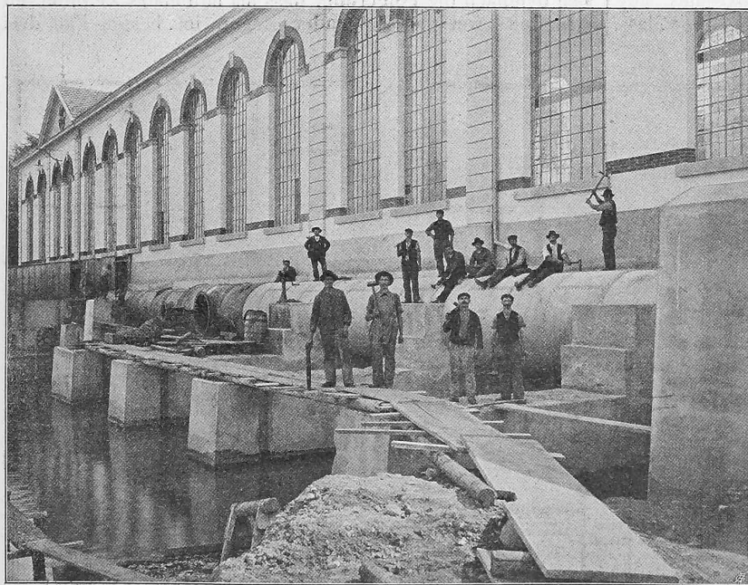
Abb. 59. Anschluss der neuen Druckleitung an die alte Kanderleitung an der Seeseite des Maschinenhauses.
