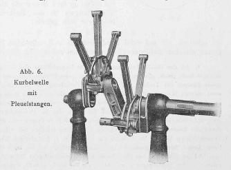
80  $kg/cm^2$  ( $\rlap/p \cdot u = 35$ ) und die um den Kurbelzapfen gelagerten Pleuelstangenenden solche von 160  $kg/cm^2$ , ebenso die Lagerungen der Pleuelstangen im Kolben. Da die relativen Geschwindigkeiten dieser auflagernden Teile gegen-
