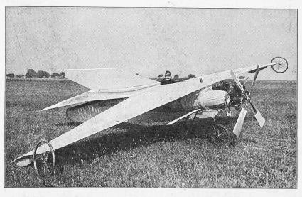
Abb. 8. Einbau des Fächermotors in den Drachenslieger Esnault-Pelterie No. 2.
