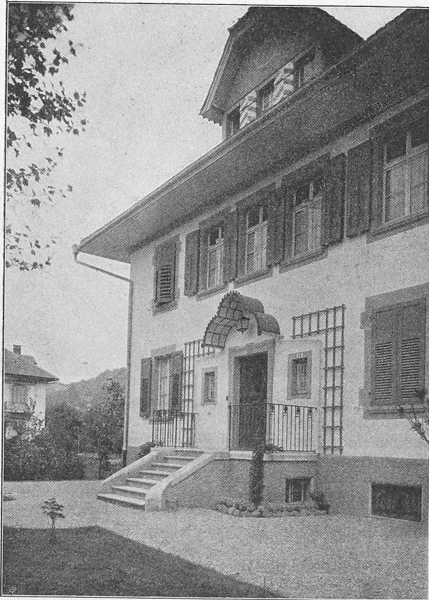
Abb. 8. Ansicht von der Strassenseite.
