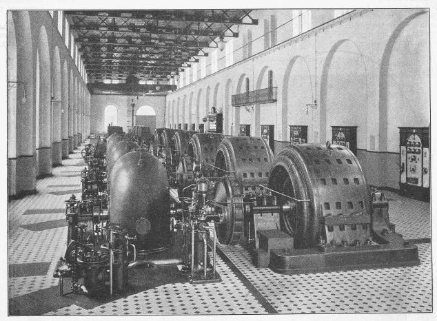
Abb. 29. Maschinensaal des Kraftwerkes in Campocologno. — Turbinenseite.
