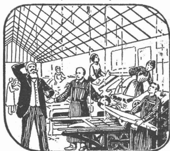
Immer Schaden durch das eingekittete Glasdach.
