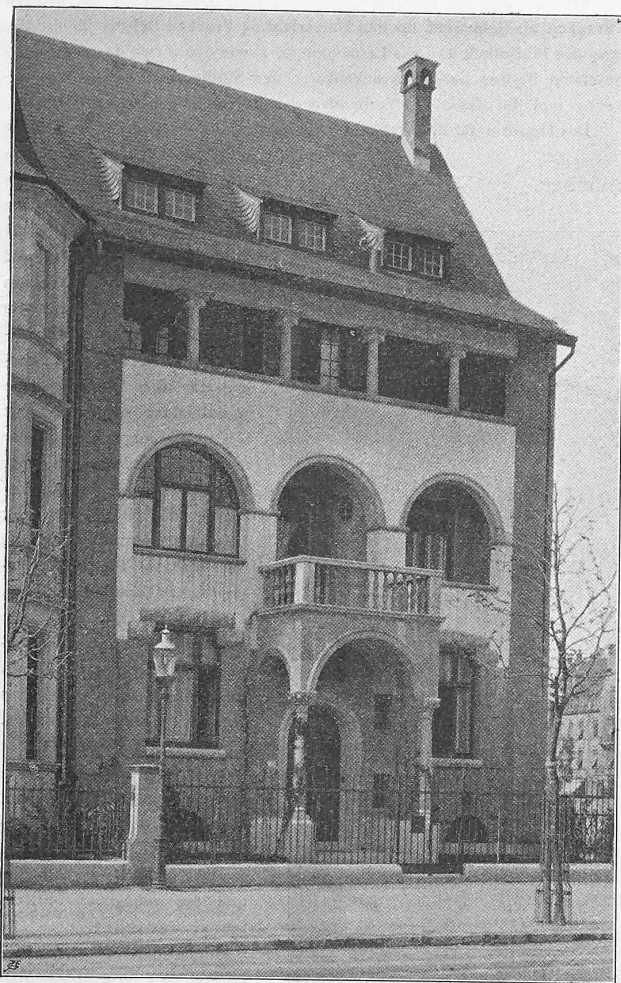
Abb. 6. Haus an der Arnold Böcklinstrasse. Erbaut von Architekt A. Visscher van Gaasbeek.
