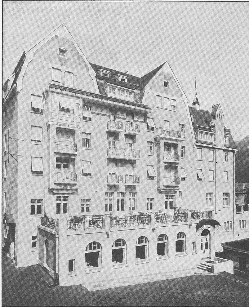
Abb. 3. Ansicht der Hauptfassade am Rosatsch-Platz.
