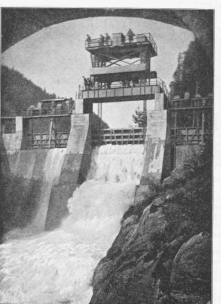
Abb. 17. Ansicht des Simmewehrs von unten bei Hebung der untern Grundablasschütze.
