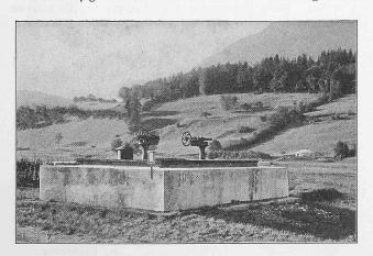
Abb. 15. Das Wasserschloss der Kanderleitung in seiner ursprünglichen Verwendung als Schieberschacht.
