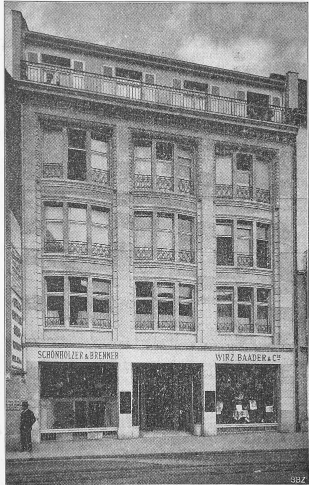
Abb. 1. Fassade des Geschäftshauses G. u. W. Baader an der Aeschenvorstadt.
