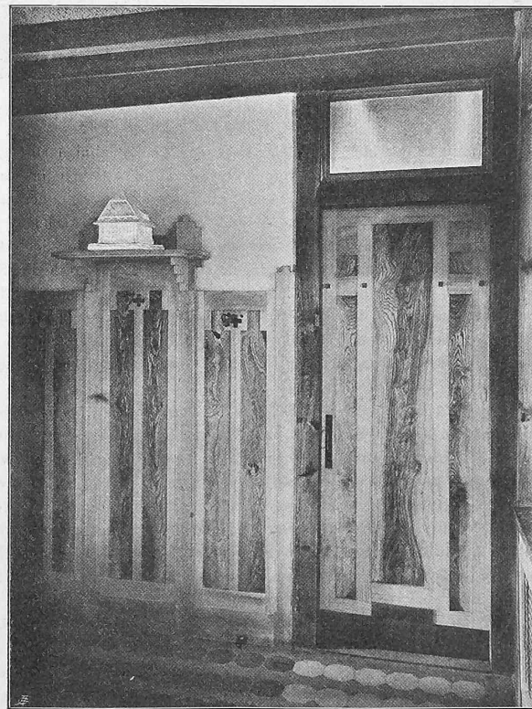
Abb. 8. Täfer in der Eingangshalle.
