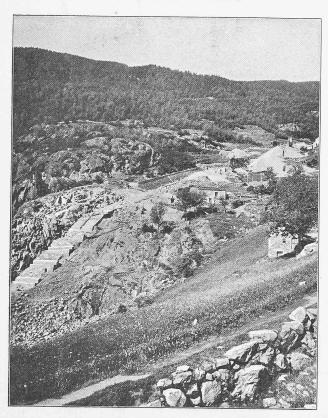
Abb. 25. Mauerfundamente zur Druckleitung.
