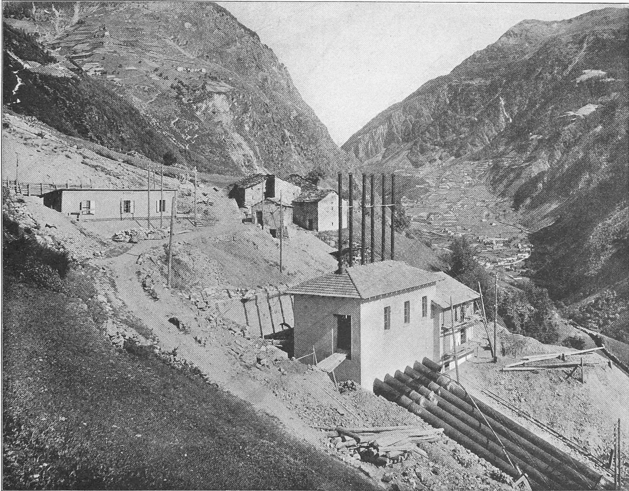
Abb. 22. Aeussere Ansicht des Wasserschlosses und des obern Schieberhauses.
